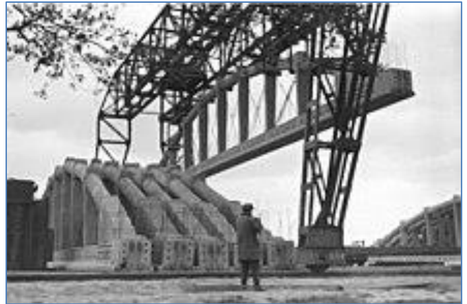
Spanbogen voor het dak: 105 stuks à 47 ton/stuk.
