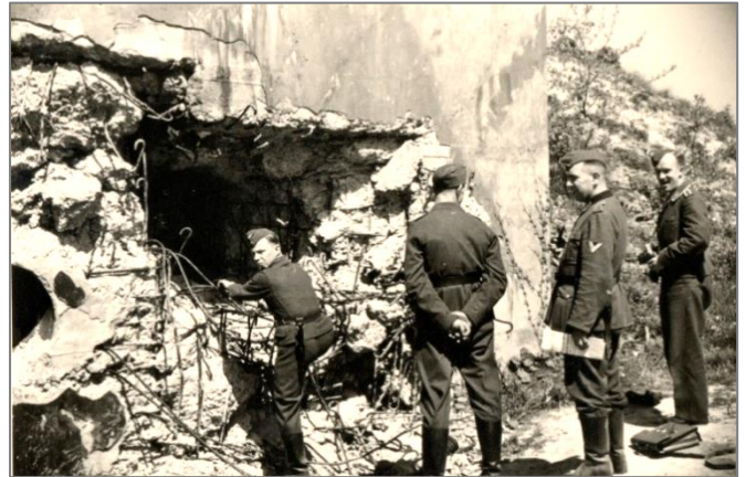
Effect van 50 Kg holle lading op bunker Mi Zuid
